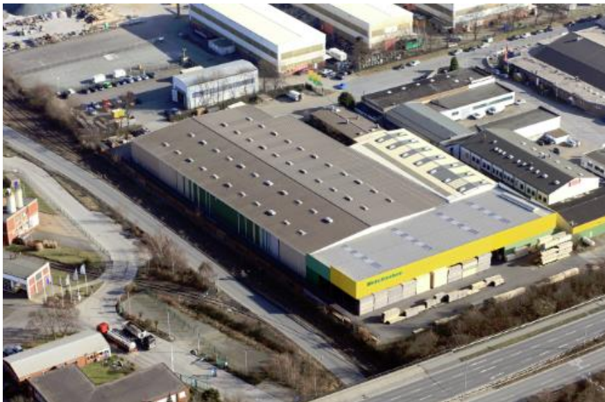
BU: Am BECHER Standort im Gewerbegebiet „Zum Eisenhammer“ in Oberhausen-Buschhausen (Fläche links oben im Bild) entsteht bis 2018 ein neues automatisiertes Lager.
