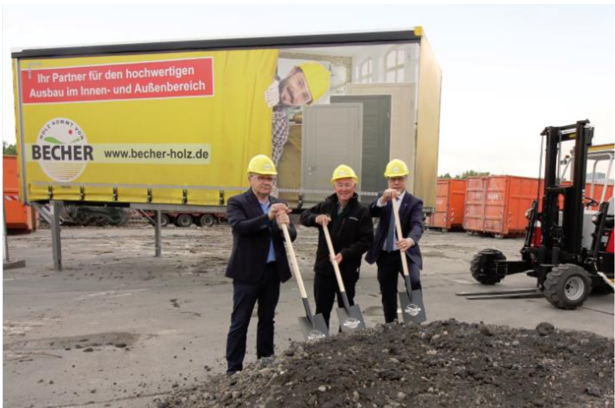
BU: Geschäftsleiter Udo Bewersdorff, Beiratsvorsitzender Gerhard Becher sowie Geschäftsführer Ulrich Griesar (v.l.n.r.) geben den Startschuss für den Lagerneubau am BECHER Standort in Oberhausen.
