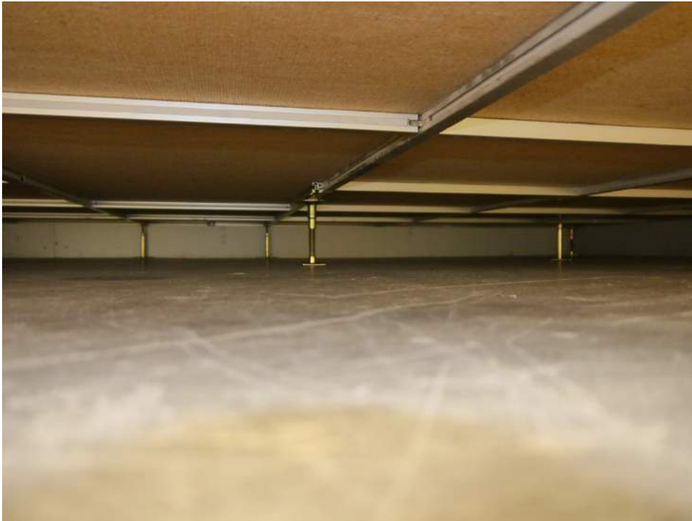
Abbildung B.5. Untersicht des Prüfaufbaus mit rückseitig aufgeklebter Holzfaserverplatte.
