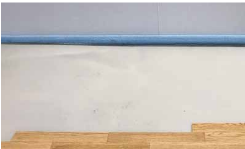
Optimal verlegter Randdämmstreifen
