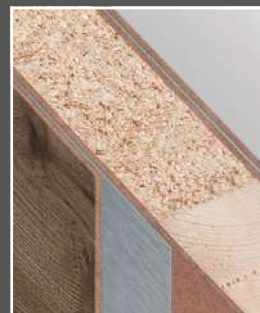
Klimaklasse III mit Aluminiumverbundabsperung
