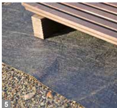
5 Wasserdurchlässiges Abdeckvlies gegen Durchwurzelung u. Pfützenbildung.
