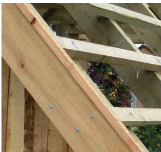
Lärchen – Dachstuhl im Detail
