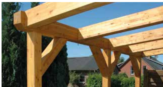
Konstruktiv gestalten: Kreatives Bauen mit getrockneter Lärche
