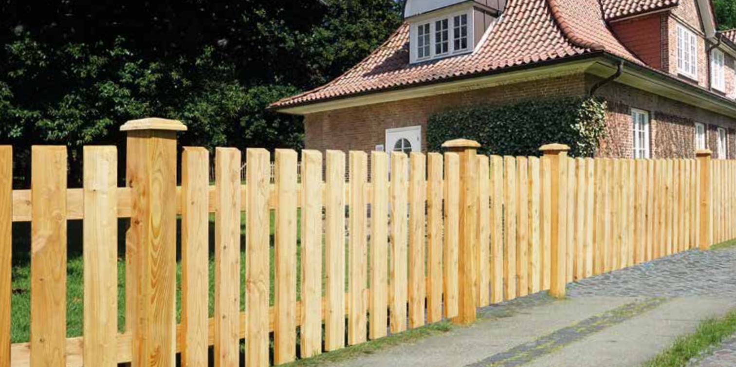
Fördezaun mit Pforte
