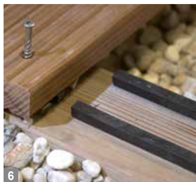
6 Praktisch: selbstklebendes Ausgleichsband reguliert Unebenheiten.
