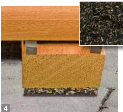
4 Gummi reguliert: Höhenausgleich-Pads für die Unterkonstruktion.
