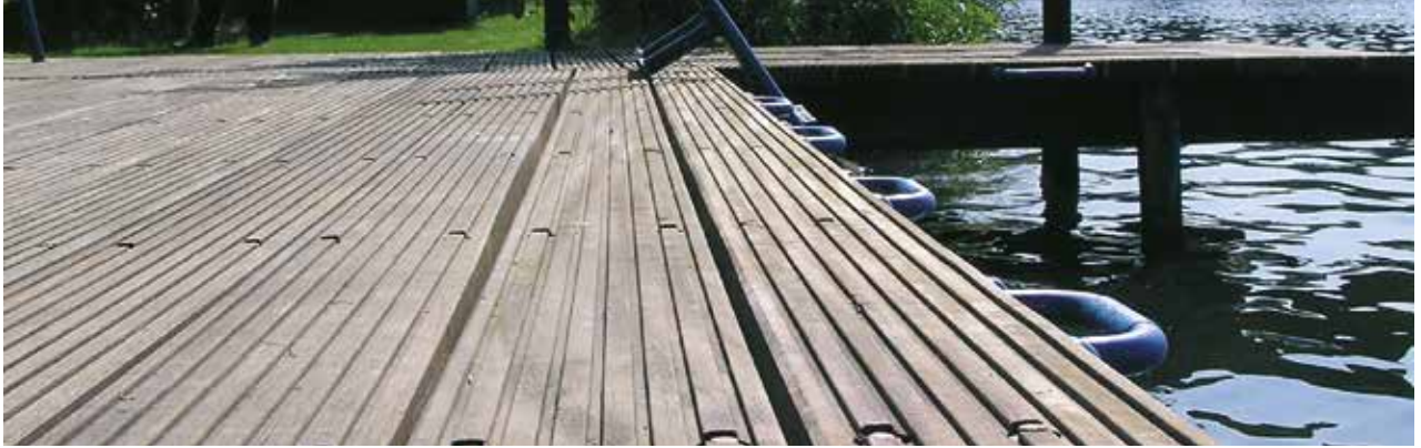
Unterkonstruktion im Wasser: Anwendungsbeispiel für Bongossi-Kanthalz
