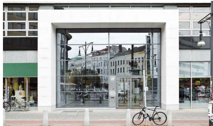
Tagsüber verbirgt sich die Lichttechnik unsichtbar und geschützt hinter der soliden HIMACS-Oberfläche.
