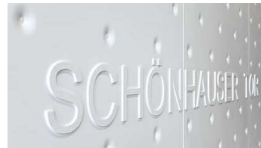
Außen effektiv bespielt, innen mit markantem Punkt-Design und mit CNC-Technik eingegrästes Schrift.
